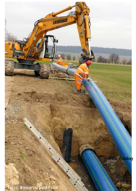
Neues Großprojekt: Das Zukunftssicherungskonzept für die Trinkwasserversorgung sieht auch Erneuerungen von Transportleitungen vor – rund 280 Millionen Euro Investitionen in 20 Jahren sind in diesem Konzept prognostiziert.
