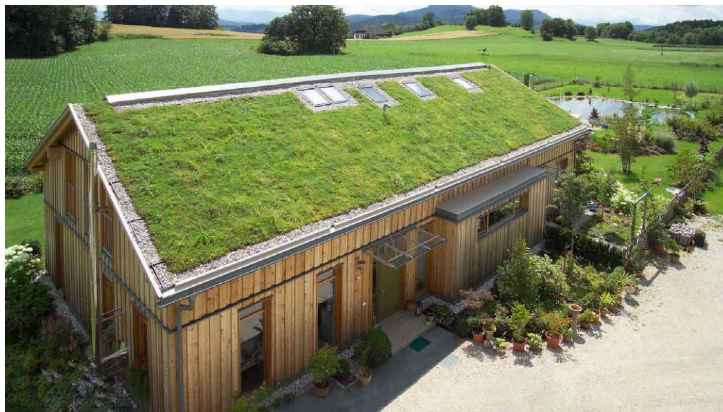
Gründächer können einen wichtigen Beitrag zum Klimaschutz leisten. Bei ihrem Aufbau muss auch das zusätzliche Gewicht beachtet werden, das sie auf das Dach bringen.
