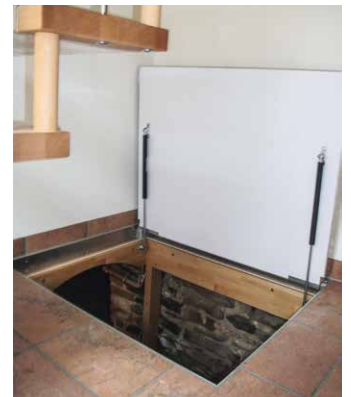
Wie ein Kofferraumdeckel: Die Bodenluken lassen sich dank Gasdruckfedern leicht öffnen und schließen. (3) Fotos: Treppenmeister
