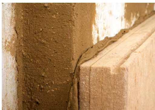
ClayTec-HFD-Innendämmung angeklebt.
