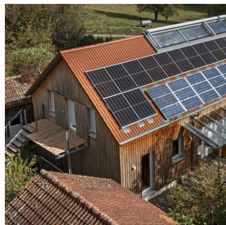
Entlastung für die Haushaltskasse, Belastung für die Dachstatik: Der Dachaufbau muss bei der Planung einer PV-Anlage mit berücksichtigt werden.
