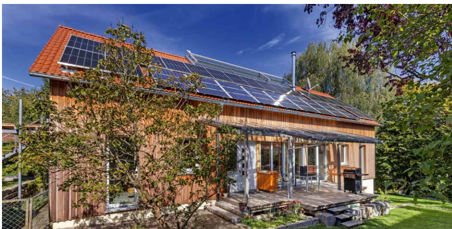
Bei der Planung einer PV-Anlage muss die statische Belastbarkeit des Dachs beachtet werden. Soll zugleich die Dachdämmung verbessert werden, sind leichtgewichtige Hochleistungsdämmungen aus Polyurethan-Hartschaum eine gute Wahl.
