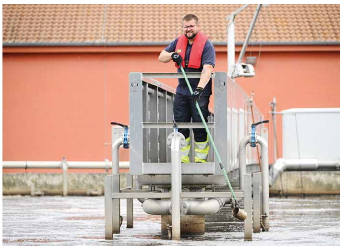
Kläranlagen sind wichtige Betriebsstandorte in der Region – wie hier in Wahle.
