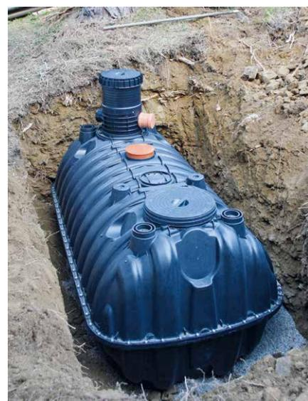
**Erdtanks bieten eine Kombination aus Regenwassernutzung und Versickerung.** Foto: Intewa/akg-o
