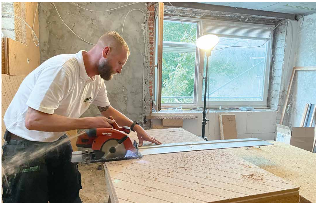
Zuschnitt der Dämmplatten mit Handkreissäge oder Stichsäge.
