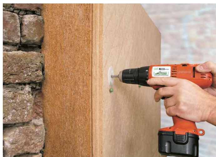
Die flexible Seite schmiegt sich hohlraumfrei an den Untergrund an und gleicht Unebenheiten von plus/minus 20 Millimeter aus.
