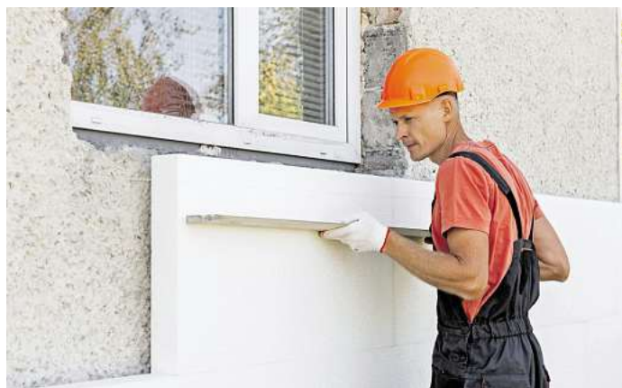
Eine Dämmung der Fassade zählt zu den wichtigsten Maßnahmen, um ältere Gebäude energetisch auf den heutigen Stand zu bringen. FOTO: DJD/IVH/GETTY IMAGES/YUNAVAI
