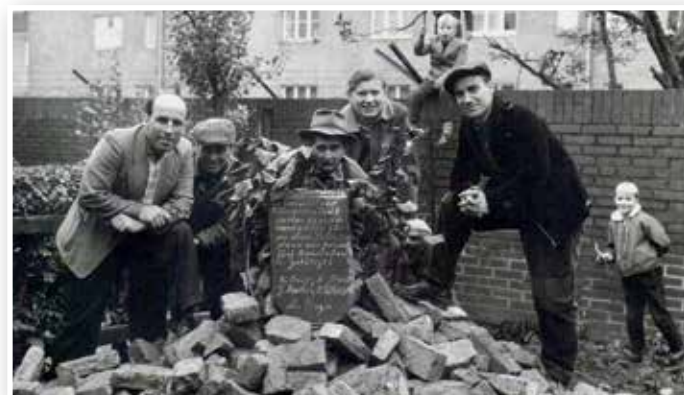
Schießstandbau „Löns-krug“ ab 1969
